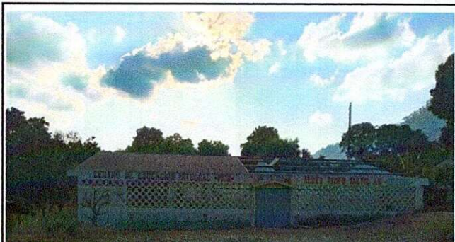
Foto1: ENTECHADO, LAMINAS EN SU TOTALIDAD EN MAL ESTADO.
