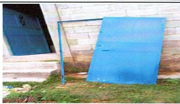
Foto 2: SUSTITUCION DE PUERTA.
